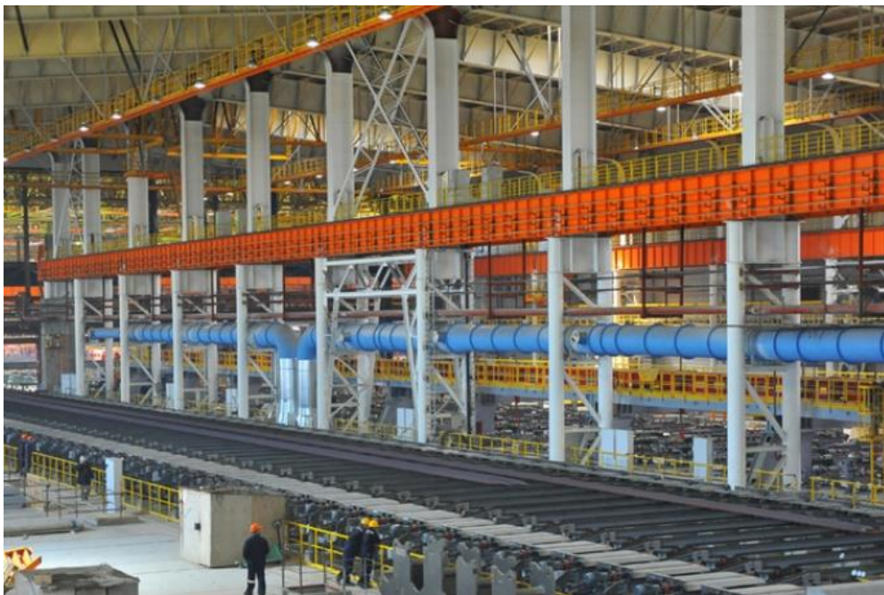
Рис.2. Рельсобалочный стан Челябинского металлургического комбината
