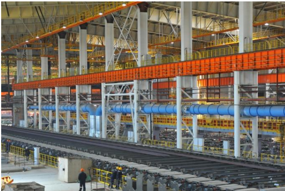
Рис. 2. Рельсобалочный стан Челябинского металлургического комбината
